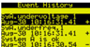
Abb. 108: Seite „Ereignisspeicher“ (Beispiel)
