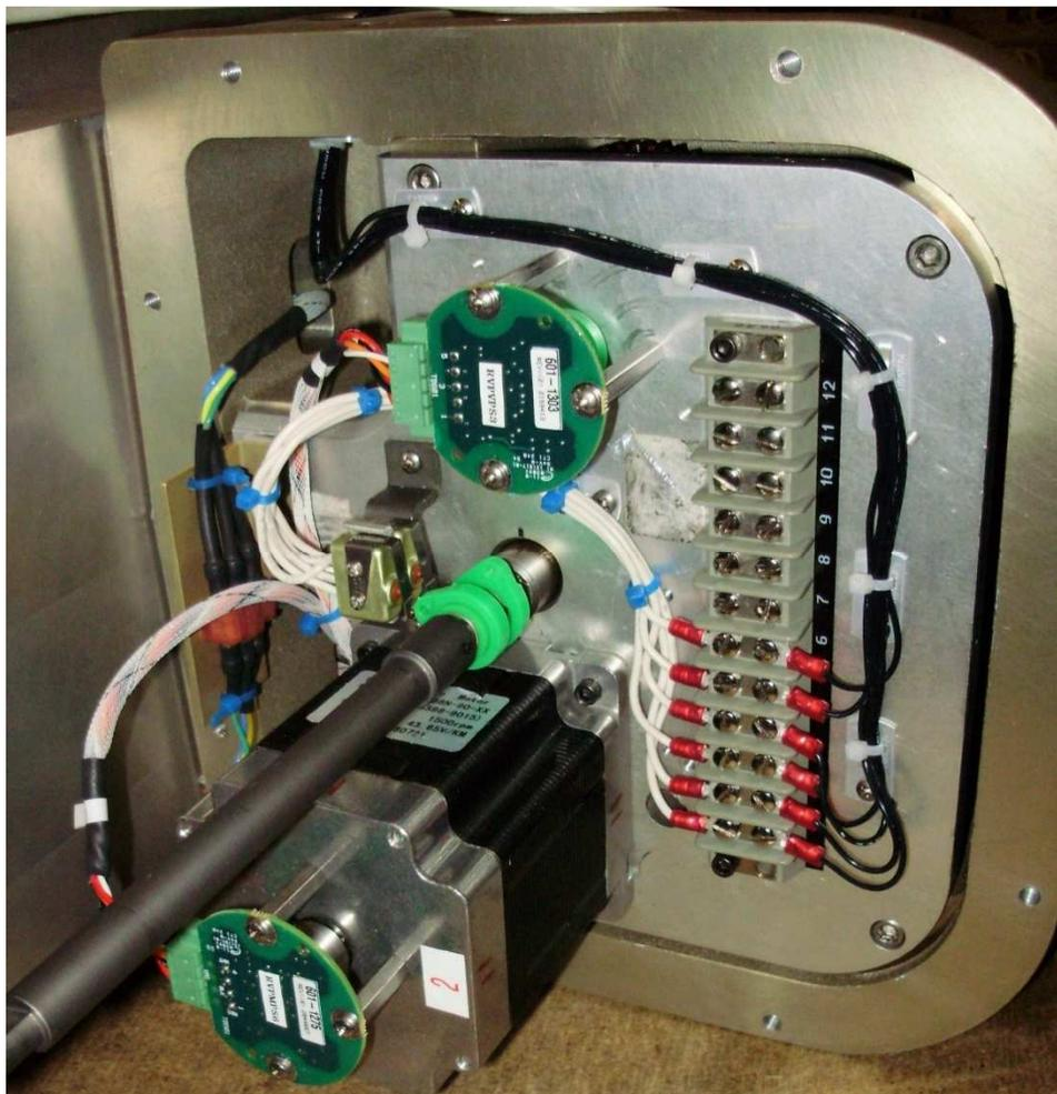
Figura 2-8. Entrada de conductos de conmutación de limitación del actuador: Sección superior izquierda
