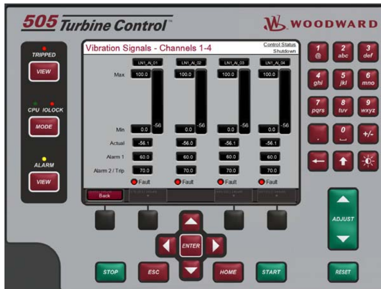
図 1-9. 振動監視ページ
